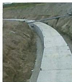
曲線部も直線部と同じ施工!
