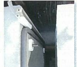
TBジョイントバー挿入状況
