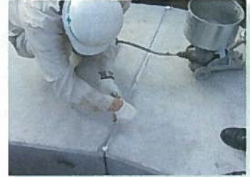
上部より頂版先端部へ注入 (曲線部)
