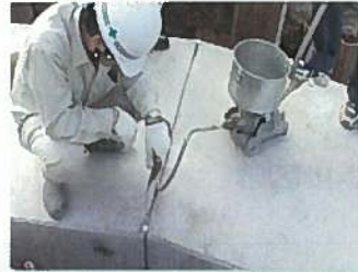
注入口より側壁部・底板部へ注入 (曲線部)
