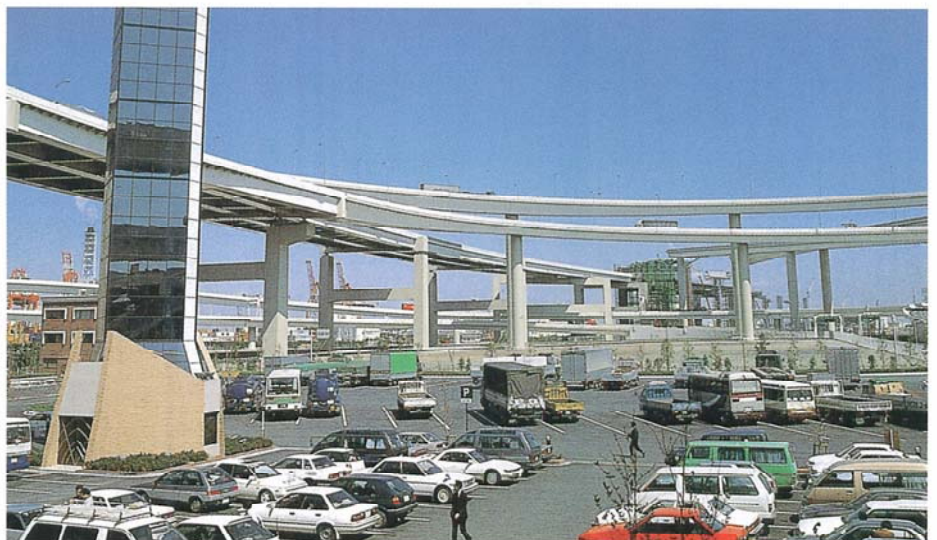
横浜 大黒埠頭インターチェンジ橋脚基礎
