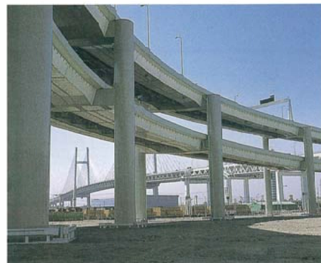
横浜 大黒埠頭インターチェンジ
