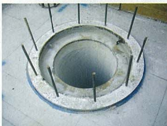
(1) 杭内面の清掃
