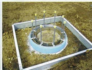
(2') PCリング下端に、モルタルを設けた場合
