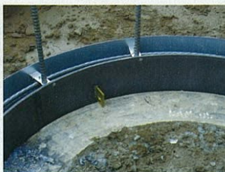
(1) 杭頭のPCリング型枠を設置後定着筋をセット
