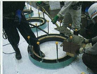
(3) コンクリート打設状況
