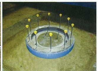
(3) コンクリート打設後
