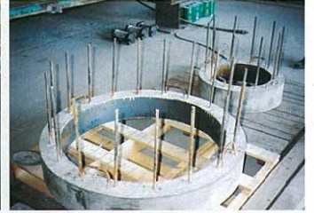
(4) 型枠脱型後
