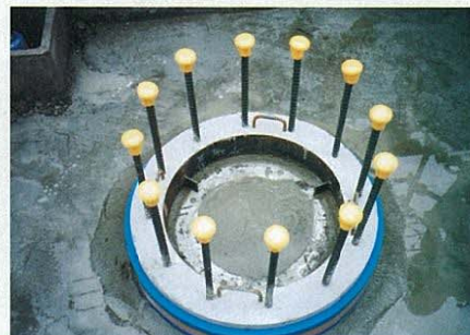
(4) PCリング設置完了
