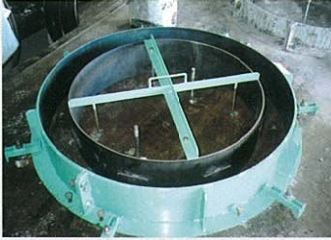
(2) 鋼板リングを型枠にセット
