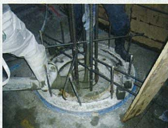
(3) 中詰コンクリート打設状況
