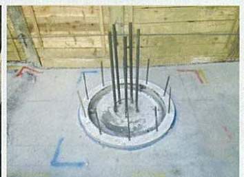
(4) コンクリート打設後
