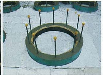
(4) コンクリート打設後
