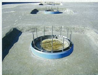
(2) PCリング下端に、発泡ポリエチレンを設けた場合
