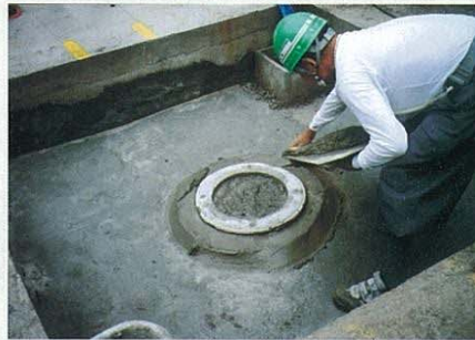
(2) 杭頭にモルタルを敷く
