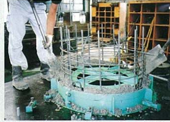
(3) コンクリート打設状況
