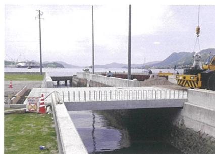
■ 標準版／地覆筋付 T-25 床版長 9,500mm 版厚 400mm
