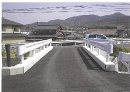
■ 標準版／地覆筋付 T-25 床版長 8,840mm 版厚 380mm
