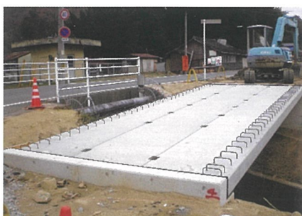
■ 標準版／地覆筋付／勾配6% T-2 床版長 8,500mm 版厚 200mm
