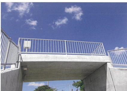
■ 標準版／地覆筋付 Q=5.0 床版長 5,800mm 版厚 180mm
