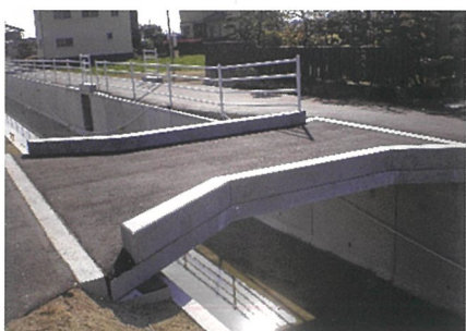
■ 異形版／地覆筋付 T-6 床版長 5,100mm 版厚 160mm
