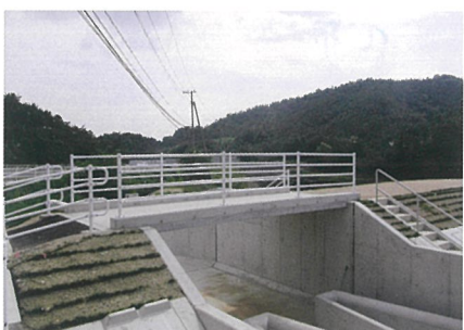
■ 標準版／地覆筋付 T-2 床版長 7,300mm 版厚 160mm
