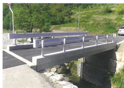
■ 標準版／地覆筋付 T-14 床版長 8,000mm 版厚 260mm
