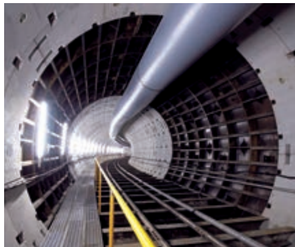
施工中のRCセグメント 写真：日本建設業連合会提供
