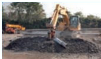
廃ポールを破碎し、鉄筋くずとコンクリートくずに分解します
