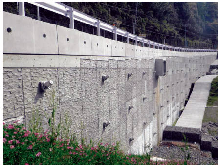
④PCW工法 (道路災害等復旧)
