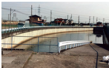
①PC-壁体 (雨水調整池の側壁)
