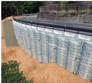
③親杭パネル (道路災害等復旧)
