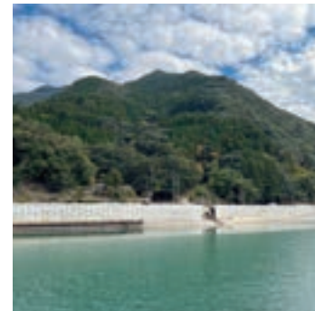
災害での早期復旧対応に使用される親杭パネル壁
