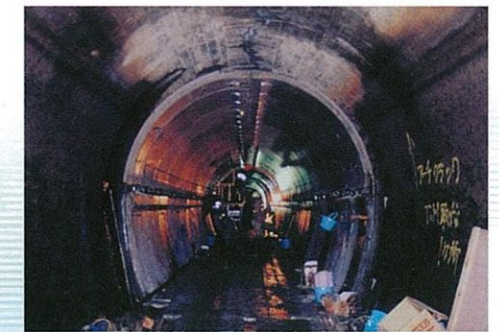
水路（補修・補強）
