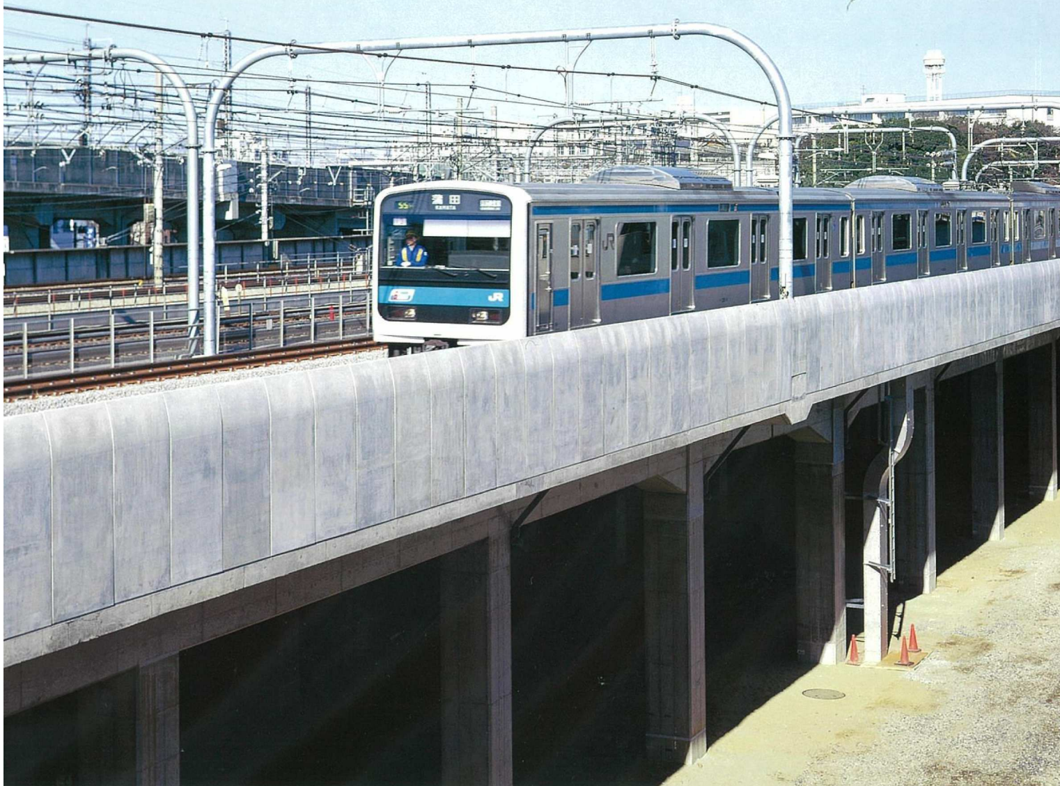
NJ軽量高欄取付状況 (JR東日本京浜東北線赤羽駅付近)
