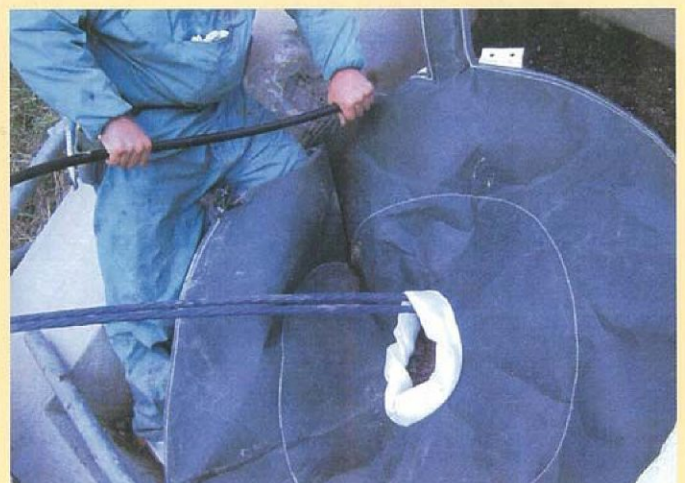
不陸調整マット設置状況
