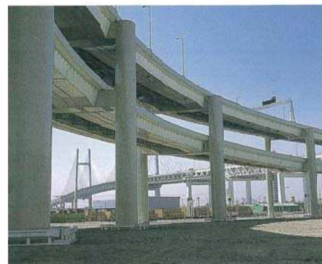
横浜 大黒埠頭インターチェンジ
