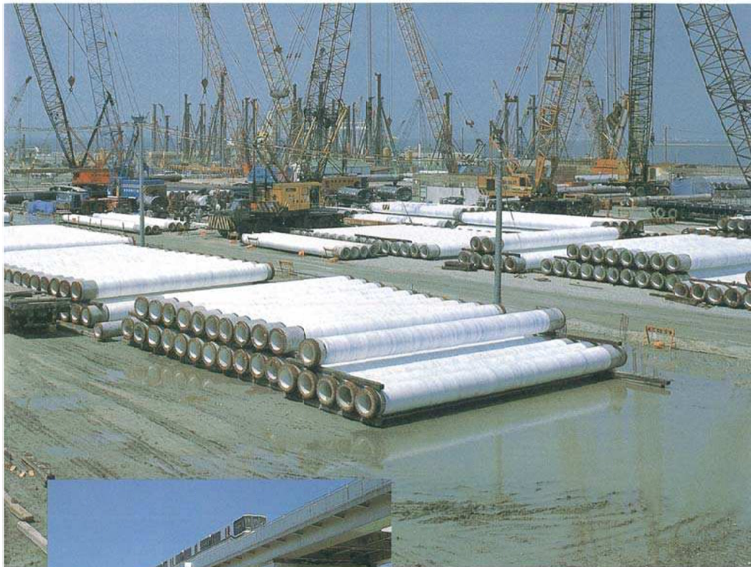
大阪 関西電力大阪南港火力発電所建設工事
