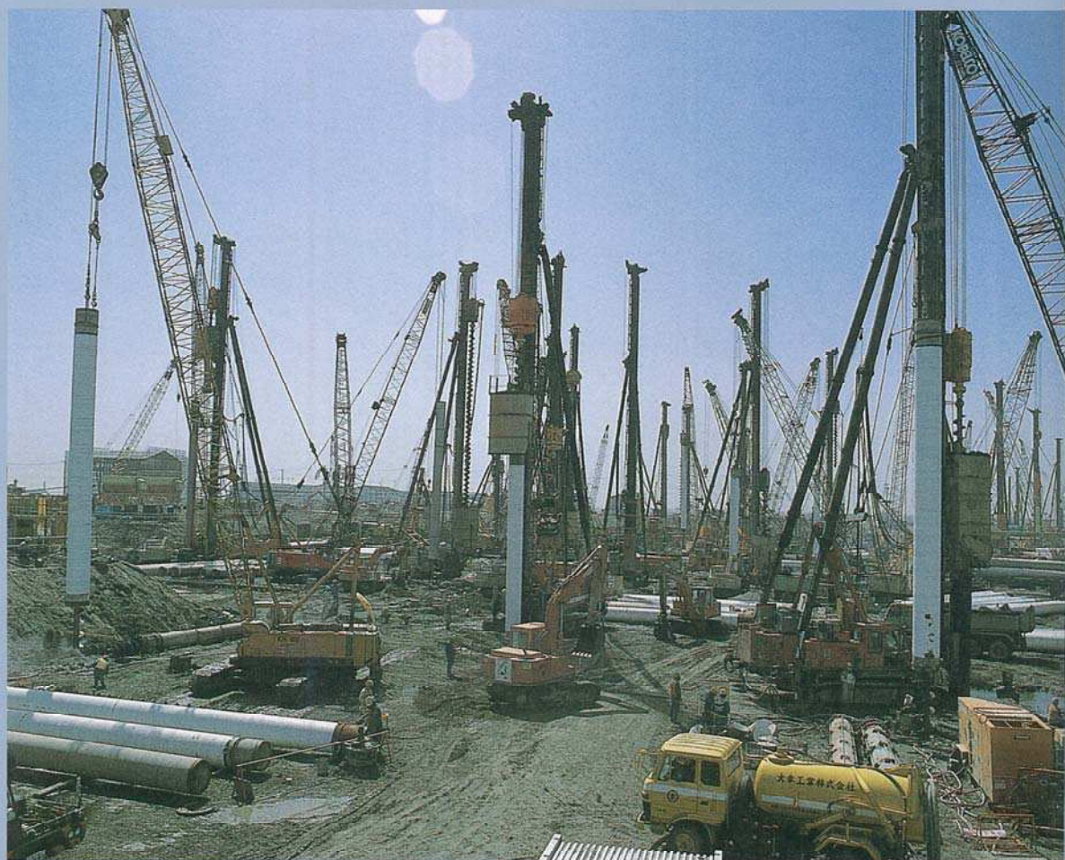
大阪 関西電力大阪南港火力発電所建設工事
