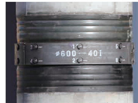
●一次締め完了
