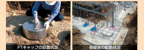
FTキャップの設置状況
