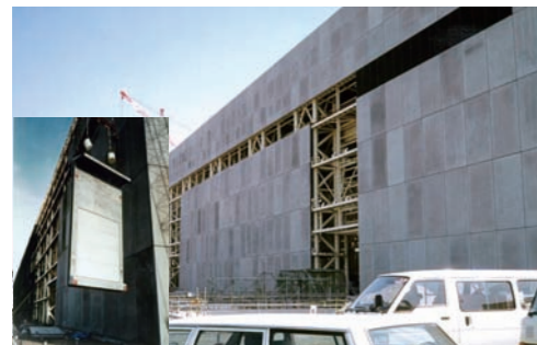
火力発電所 製品名：ポアセル 70P 工 法：PC打込み工法
