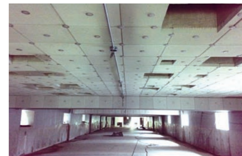
変電所蓄電池システム(断熱材) 製品名：ポアセル 50W 工 法：接着工法(RC:天井面)
