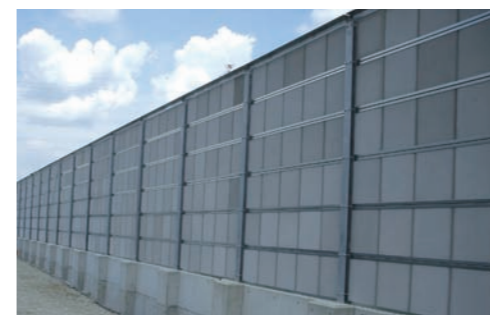
物流センタートラックヤード 製品名：アドバンテージ61 工 法：H鋼落とし込み工法
