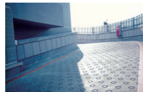
斜路側壁吸音 製品名：ポアセル 50W 工 法：接着工法(RC:壁面)
