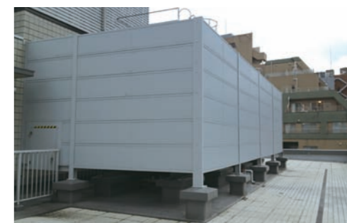
オフィスビル屋外機置場 製品名：アドバンテージ61 工 法：H鋼落し込み工法 (外壁塗装)
