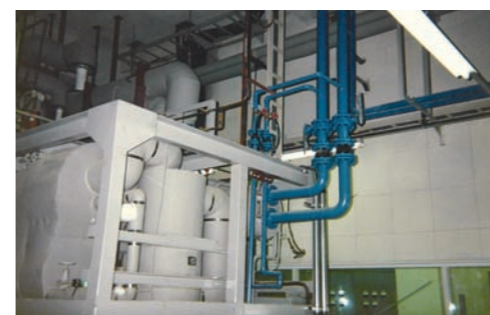
冷凍機室 製品名：ポアセル 50P 工 法：接着工法 (RC:壁面)
