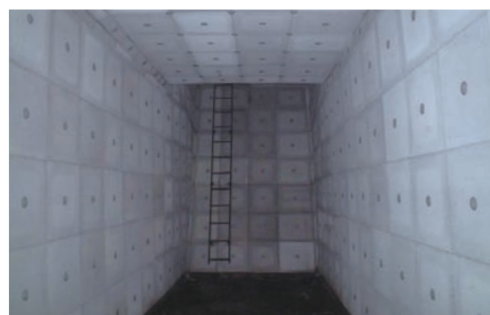
地下鉄給排気換気施設 製品名：ポアセル 50W 工 法：接着工法(RC:壁、天井面)
