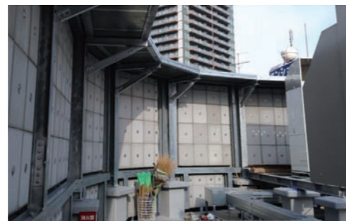
学校屋外機置場 製品名：ポアセル 100W 工 法：接着工法(押出成形板:壁面) 干渉型パネル金具止め工法(天井面)
