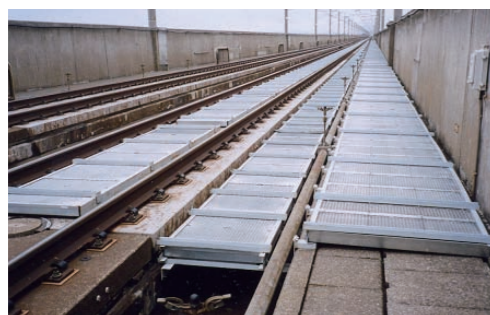
鉄道路盤面 製品名：ポアセル路盤面吸音パネルt=50(下地:RC) 工 法：金具止め工法(床面)
