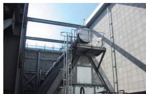
清掃工場 製品名：ポアセル 50W 工 法：接着工法 (ALC:壁面)
