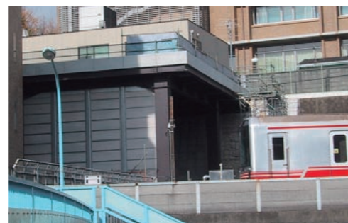
トンネル施設 製品名：アドバンテージ61 工 法：H鋼落とし込み工法
