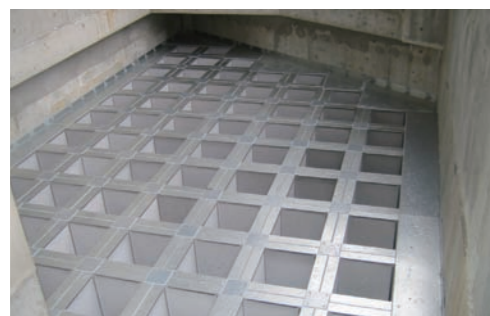
ホテル換気シャフト 製品名：ポアセルサイレンサー (U330) 工 法：縦積工法
