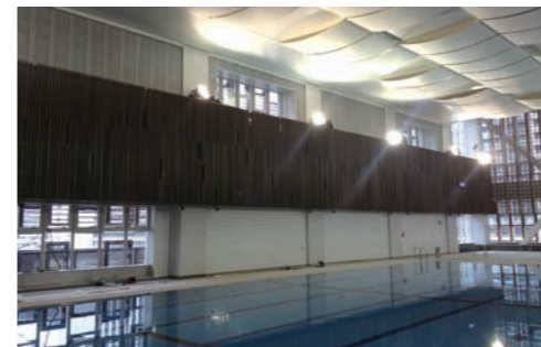
屋内プール 製品名：ポアセル 30W 工 法：接着工法 (押出成形板:壁面)
