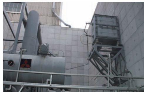
火力発電所 製品名：ポアセル 50W 工 法：接着工法 (ALC:壁面)
