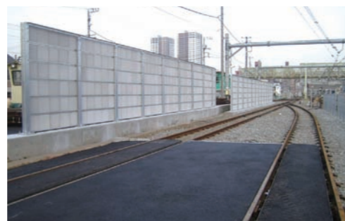
鉄道側道付近 製品名：アドバンテージ61 工 法：H鋼落とし込み工法
