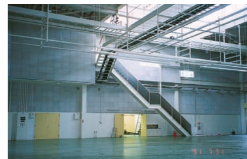
印刷工場 製品名：ポアセル 50P 工 法：接着工法 (スパンクリート:壁面)
