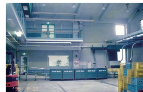
リサイクルセンター 製品名：ポアセル 50P 工 法：接着工法 (RC:壁面)
