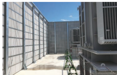
変電所 製品名：アドバンテージ61 工 法：H鋼落し込み工法
