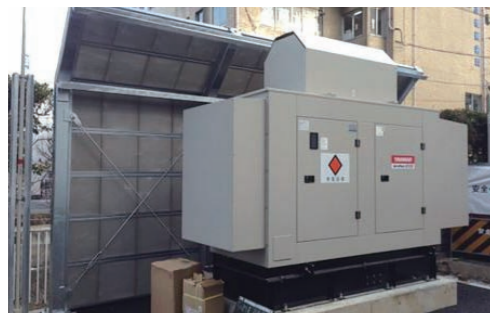
自家発電機 製品名：アドバンテージ61 工 法：H鋼落とし込み工法
