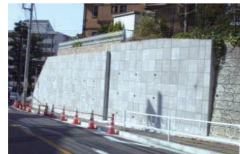
コンクリート法面吸音 製品名：ポアセル 50W 工 法：接着工法(RC:壁面)
