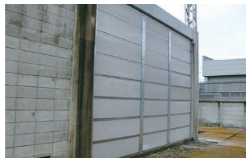
変電所 製品名：アドバンテージ61 工 法：建込み工法
