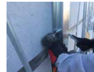
押さえアングル取付
