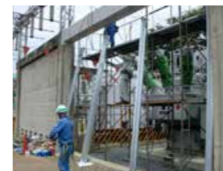
支柱建て込み
