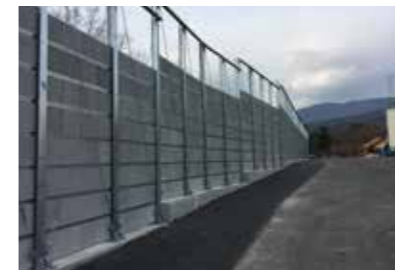
プラント施設
