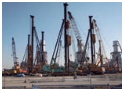
基礎杭打設現場
