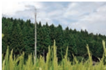
フランジ継手式ハイポール (携帯電話用アンテナ基地局)
