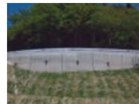
災害復旧後状況（その2）
