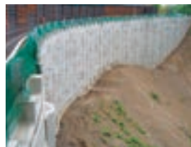
災害復旧後状況（その1）
