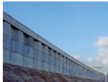
親杭パネル壁施工例
