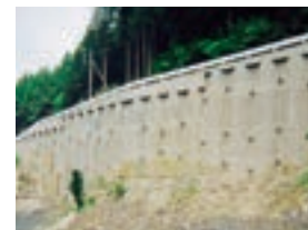
道路拡幅後状況（その2）
