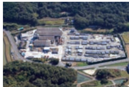
NC貝原パイル製造株式会社 和気工場
