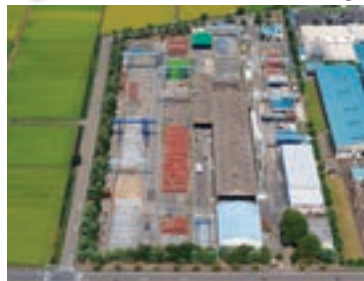
NCセグメント株式会社 板倉工場
