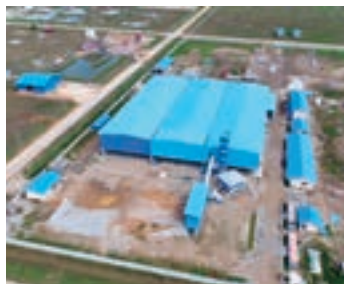
NIPPON CONCRETE (Myanmar) Co., Ltd. モーラマイン工場
