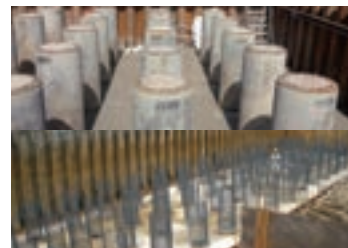
RSCP杭の打設後におけるカットオフ作業前後の様子です。詳しくはP.7のトピックスをご覧ください。
