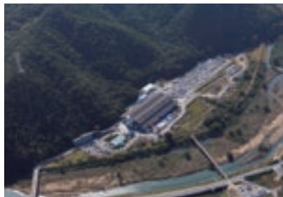
NCプレコン株式会社 岡山工場
