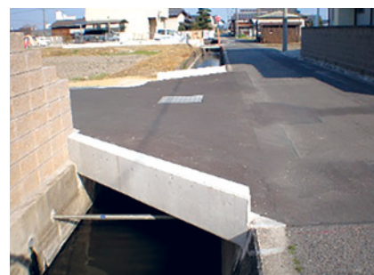
■グレーチング版/地覆筋付 T-25 床版長 2,600mm 版厚 220mm
