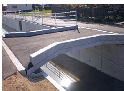
■異形版/地覆筋付 T-6 床版長 5,100mm 版厚 160mm
