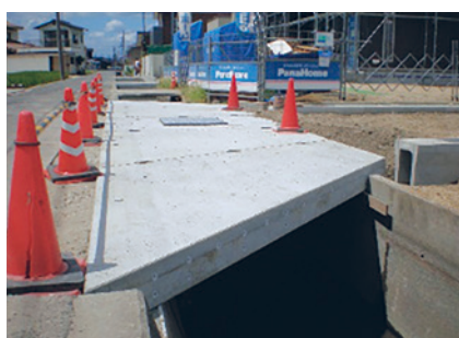
■異形G版/側面インサート埋設 T-25 床版長 2,600mm 版厚 220mm
