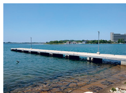
■標準版/地覆筋付 T-6 床版長 4,980mm 版厚 160mm
