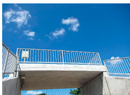
■標準版/地覆筋付 Q=5.0 床版長 5,800mm 版厚 180mm
