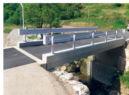
■標準版/地覆筋付 T-14 床版長 8,000mm 版厚 260mm
