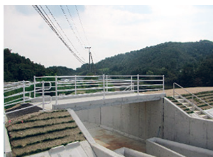
■標準版/地覆筋付 T-2 床版長 7,300mm 版厚 200mm
