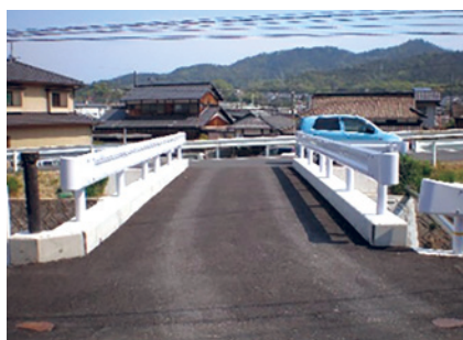
■標準版/地覆筋付 T-25 床版長 8,840mm 版厚 380mm
