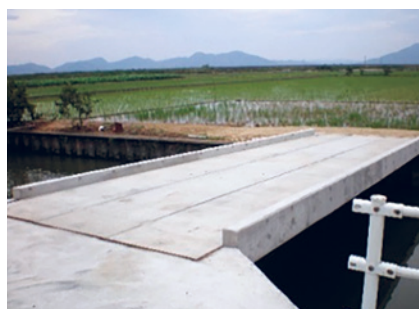
■標準版/地覆筋付 T-8 床版長 11,000mm 版厚 280mm
