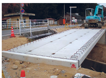
■標準版/地覆筋付/勾配6% T-2 床版長 8,500mm 版厚 200mm
