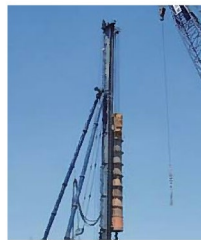
テレスコ型飛散防止装置
