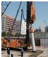
杭吊り装置 (下杭)
