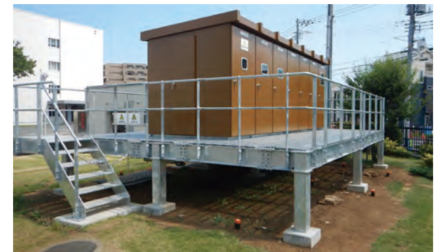
受変電設備嵩上げ架台基礎 [杭明細] φ216.3/L=5m/9set [杭および架台施工] 2025年3月
