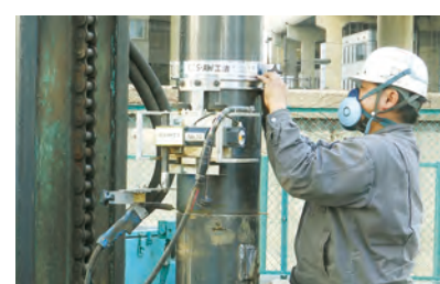
継手位置に合わせてセッティング ECS-AWを、継手位置に合わせて上杭にセットします。
