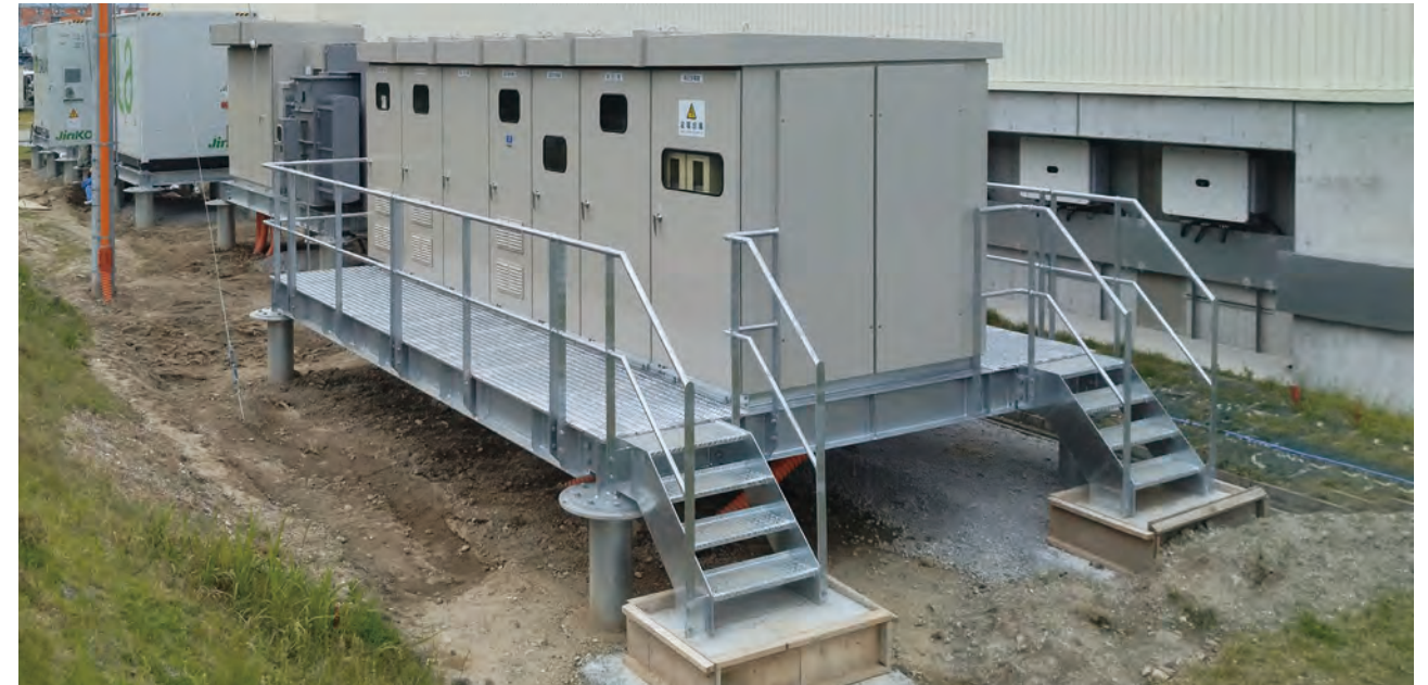
蓄電所架台基礎 [杭明細] φ267.4/L=5m/8set [杭および架台施工] 2025年4月
