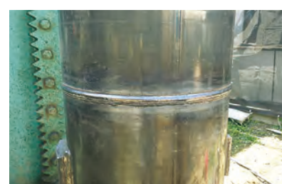
溶接完了 ECS-AWを取り外し、スラグ、スパッタを除去して施工完了です。
