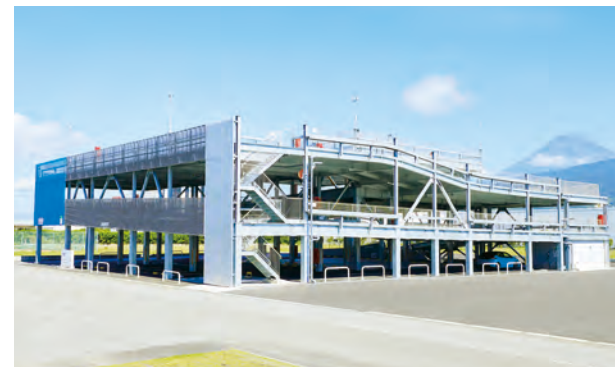
静岡県立体駐車場 [杭明細] φ318.5/L=8m/6set φ406.4/L=8m/48set [杭施工] 2018年3月
