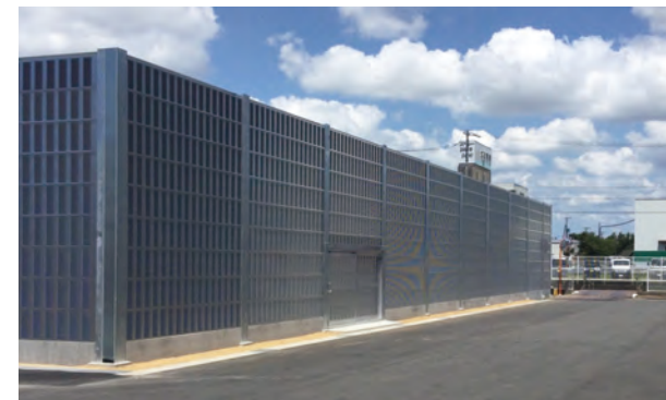
静岡県工場防音壁 [杭明細] φ267.4/L=5m/20set [杭および防音壁施工] 2023年7月
