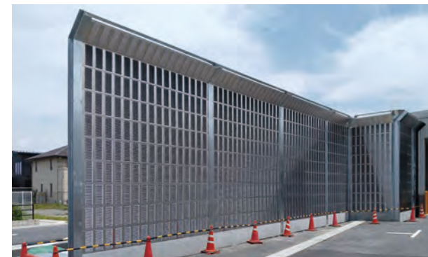
商業施設防音壁 [杭明細] φ216.3/L=3.5m/7set [杭および防音壁施工] 2024年7月
