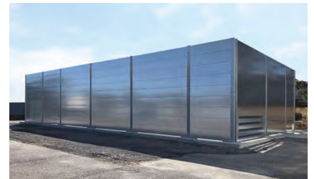
宮崎県工場防音壁 [杭明細] φ267.4/L=4m/18set [杭および防音壁施工] 2025年2月
