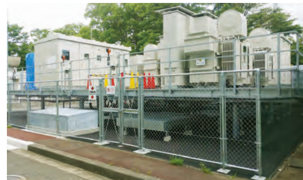
川崎市設備架台 [杭明細] φ190.7/L=6m/18set [杭施工] 2022年1月
