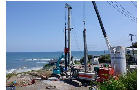
リーダー式ケーシング掘削機 プレボーリング工法
