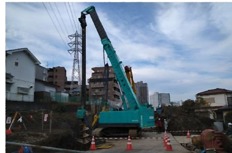
懸垂式杭打機 プレボーリング工法
