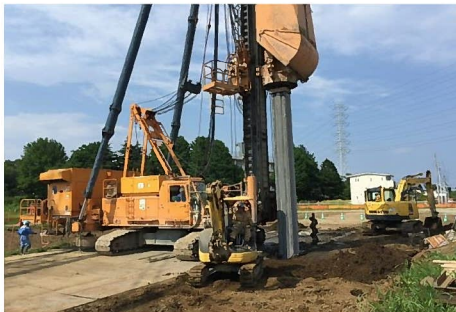
三点式杭打機 中掘り工法
