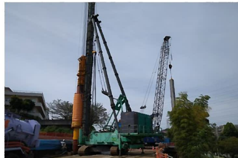
三点式杭打機 プレボーリング工法
