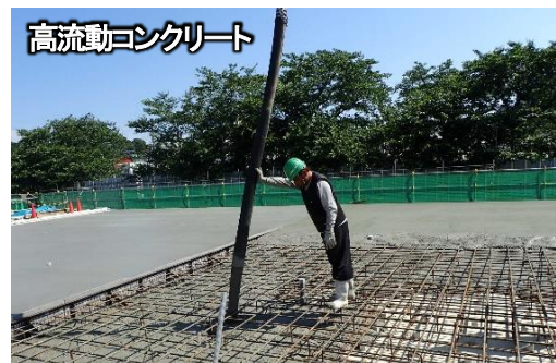
通常のコングリートと高流動コンクリート打設時の状況比較
