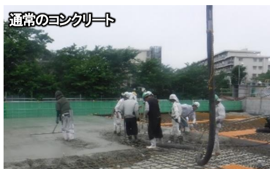
通常のコングリートと高流動コンクリート打設時の状況比較
