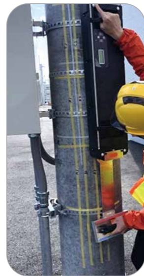
非破壊検査（磁気ストリーム法）
