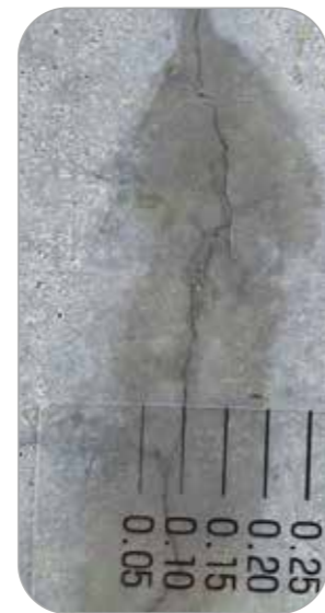
目視やクラックスケールで異常の有無を点検
