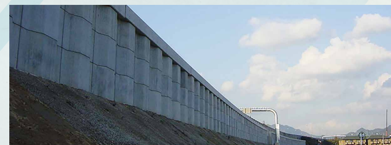
美濃関ジャンクション工事
