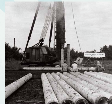
ONAパイルのハンマー打撃試験
