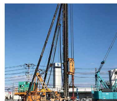
既製コンクリート杭工事
