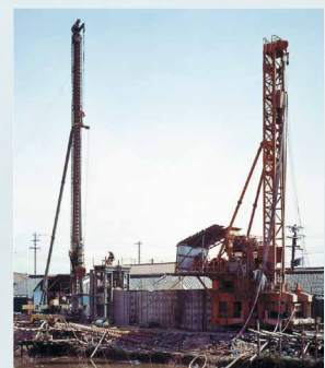
寝屋川護岸工事
