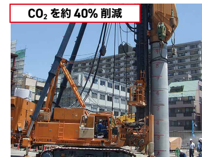
①グリーン-ONAパイル
