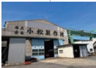
株式会社小松製作所 千葉工場
