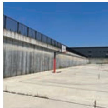
インフラ整備の一端を担うPC-壁体 (松伏調整池 (埼玉県))
