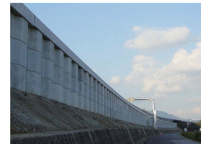
美濃関ジャンクション工事
