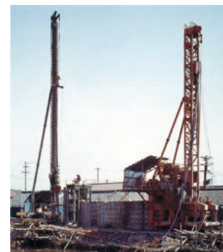
寝屋川護岸工事
