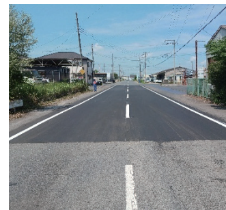
茨城県鹿嶋市道における舗装施工
