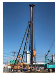
既製コンクリート杭工事
