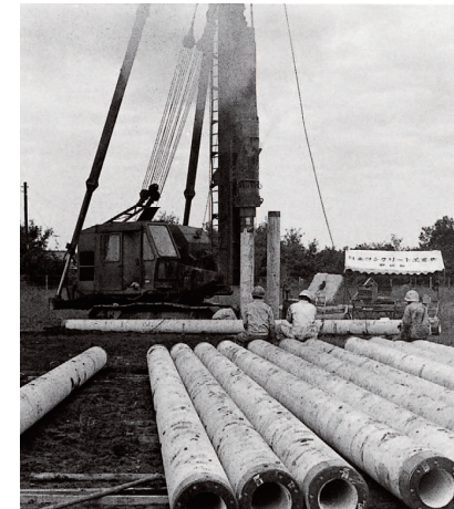
ONAパイプのハンマー打撃試験
