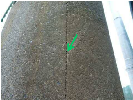
ポール製造時の型枠合わせ目に経年により生じた目開き
