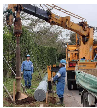
① 建柱車による掘削
