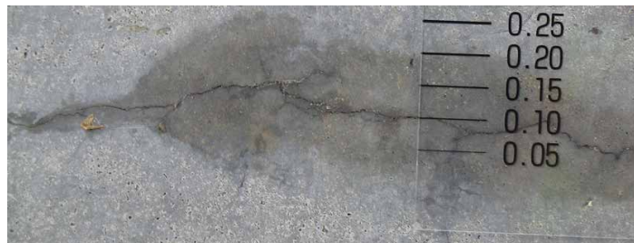
クラックスケールによるひび割れ幅測定
