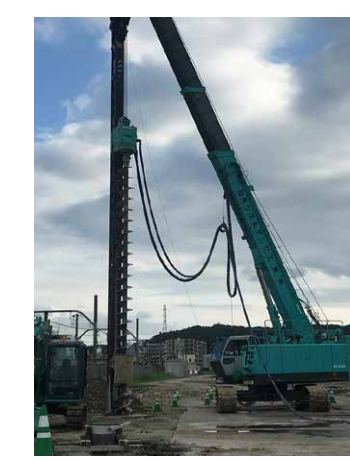
① 杭打機による掘削
