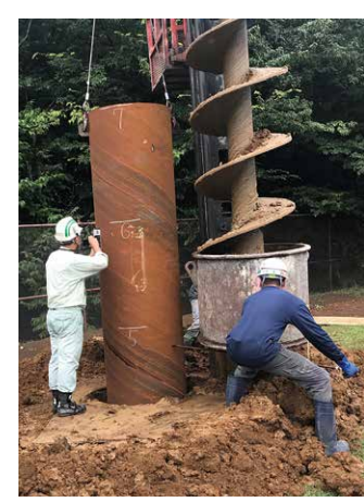
② クレーンによる基礎体埋設
