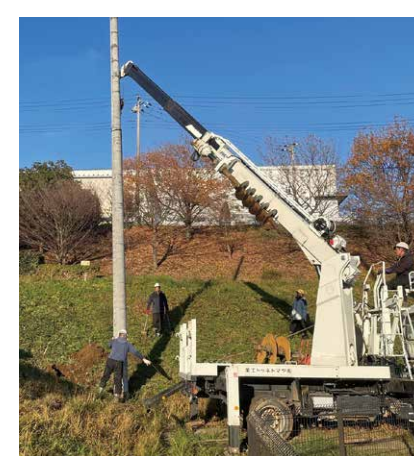
② 建柱車によるポール建込
