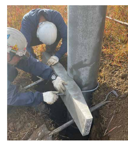
③ 根柵設置
