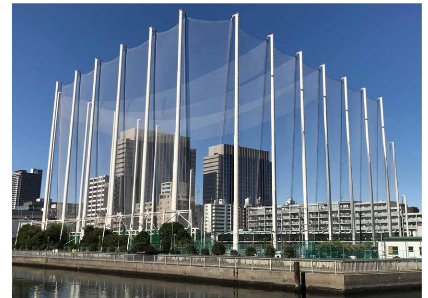
SCポール納入現場
